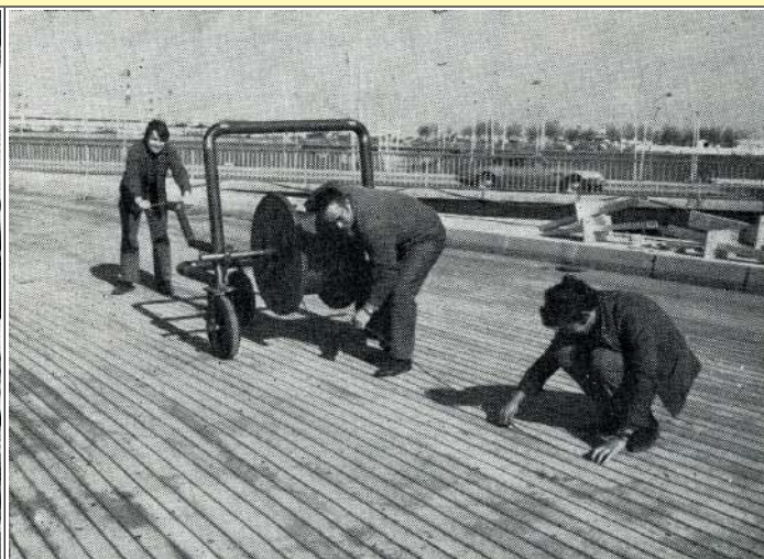
1968年，在巴黎附近的奥利机场的公共汽车停车平台的入口坡道上安装了供热网(电的地板采暖，由罗伯特·费利克斯提供，1971年，Ultimheat博物馆*)
